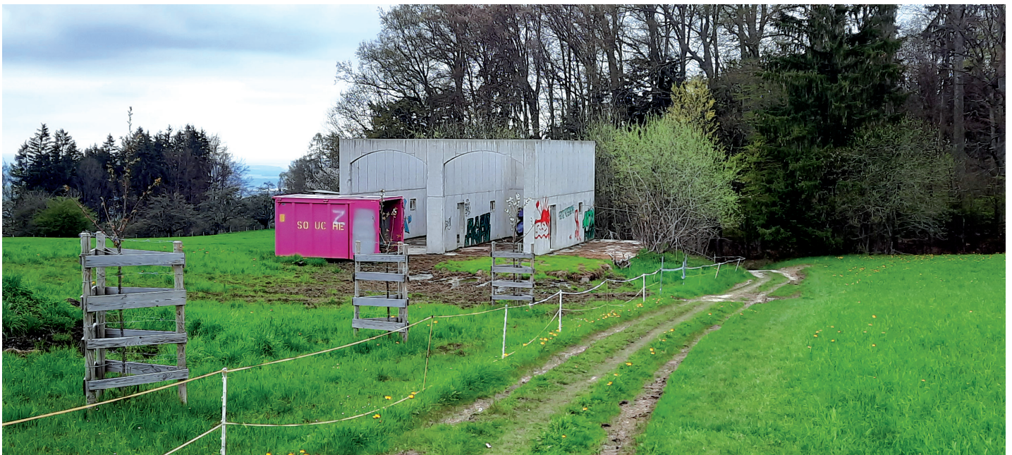
Der Betonbau stammt bereits aus 2015 und beschäftigt seitdem Behörden und Gerichte.
