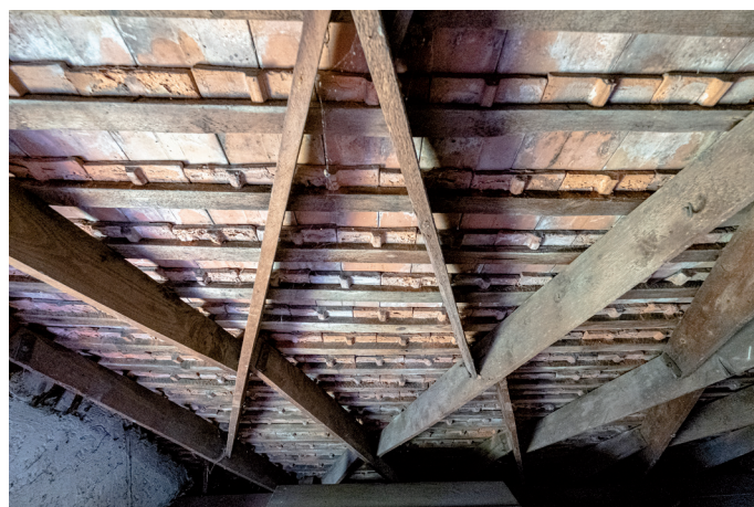
Einblick in die Zollbauweise – das Lamellendach
