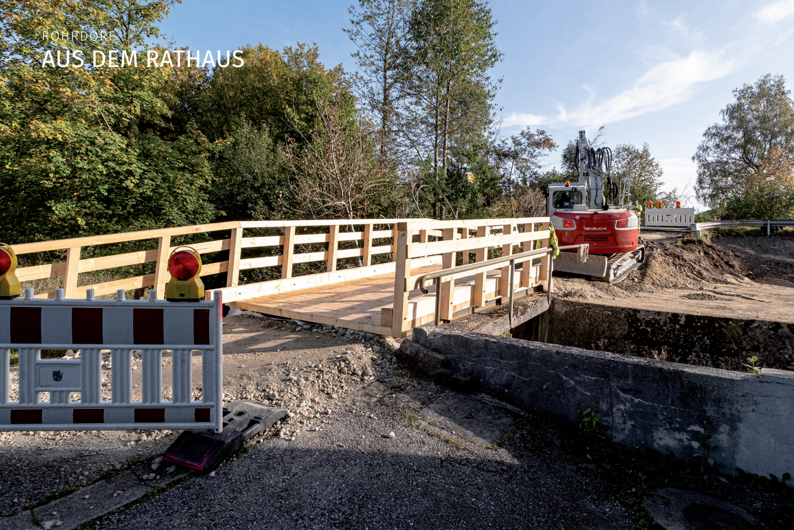
Verstärkung der Behelfszufahrt über den Speckbach
