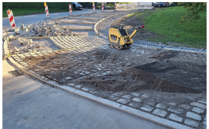
Erstellung neuer Parkplätze an der Bucher Straße
