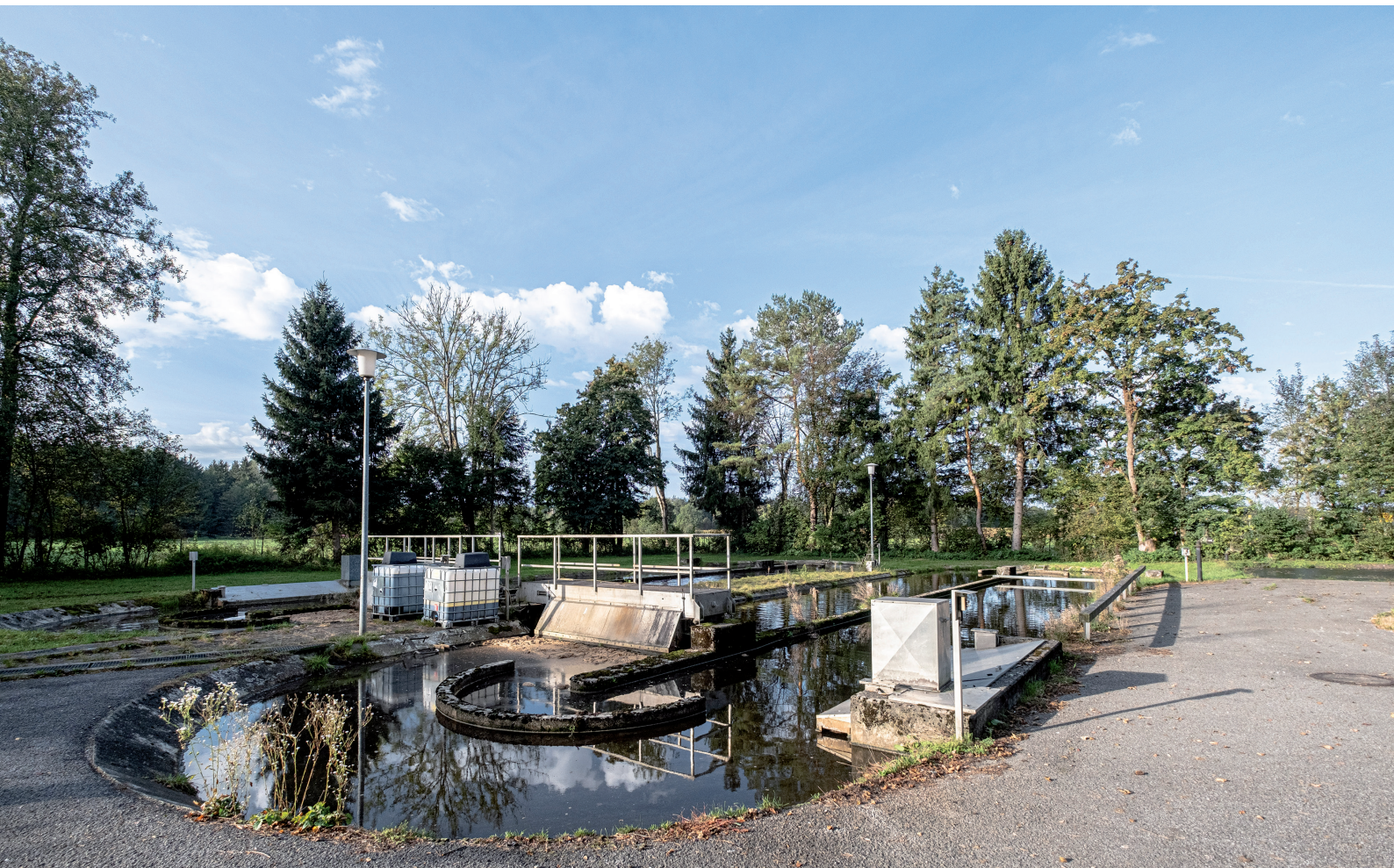
Die beiden Oxidationsbecken der Lauterbacher Kläranlage
