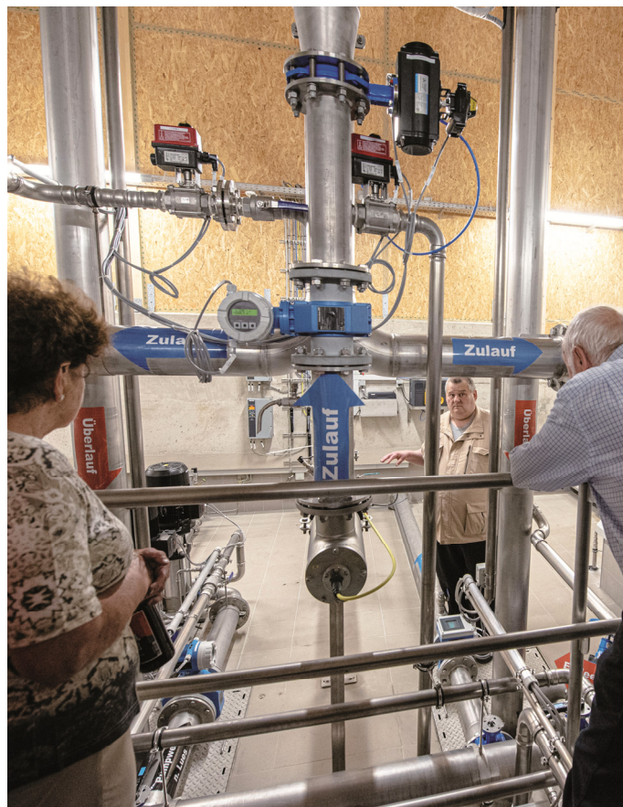
Wasserwart Gert Deutinger bei einer Führung durch den Hochbehälter
