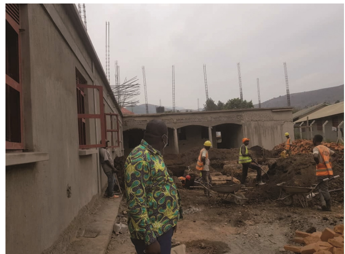
Neubauarbeiten auf dem neuen Gelände
