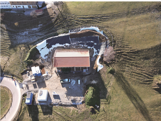
Blick aus der Vogelperspektive auf die Baustelle für den Hochbehälterneubau Taffenreuth
