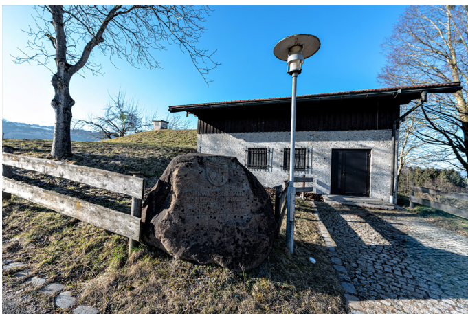
Der Hochbehälter in Apfelkam muss in den nächsten Jahren saniert werden
