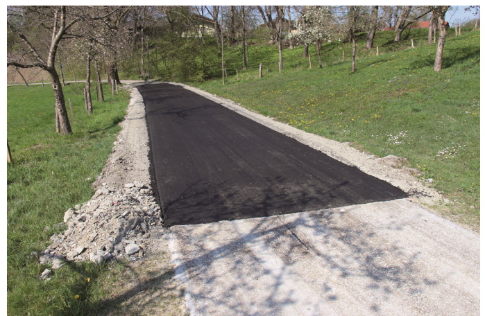
Danach wurde die neue Asphaltdecke aufgebracht
