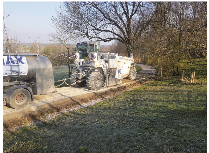
Der Untergrund des Weges wurde zuerst dauerhaft stabilisiert
