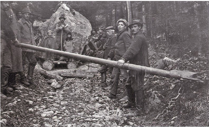
Rechte Reihe: 1. Andreas Urscher, 3. Stocker Michael, 4. Fischer Johann. Die Querstange ist ein Reitzelzug, mit dessen Hebelkraft der Felsblock gezogen wurde. Foto von Gertraud Leitner
