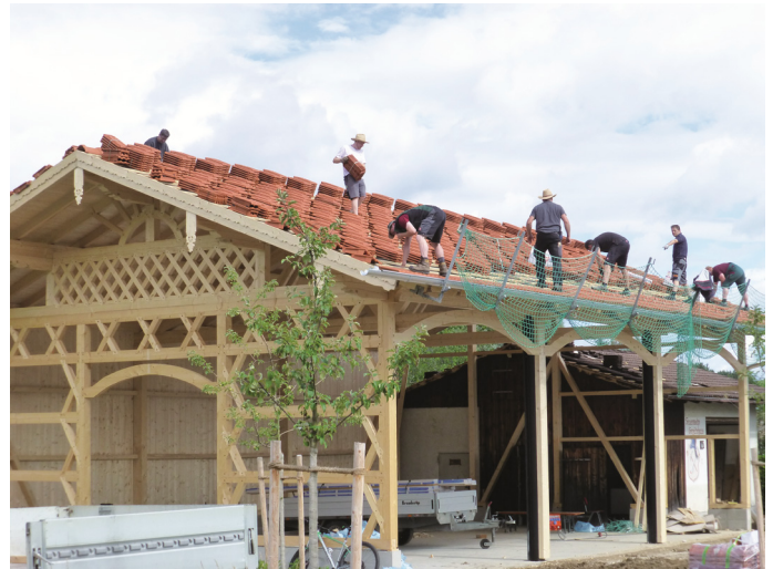
Mit der Unterstützung der Gemeinde Rohrdorf bauen die Lauterbacher Vereine 2017 größtenteils in eigener Arbeitsleistung einen neuen Stall zur Unterbringung des Inventars
