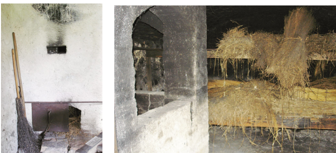
Die Abbildung links zeigt unten das Schürloch und oben einen Zuluftregler im Willinger Brechhaus. Die Abbildung rechts zeigt die Öffnungen für den Hitzeaustritt
