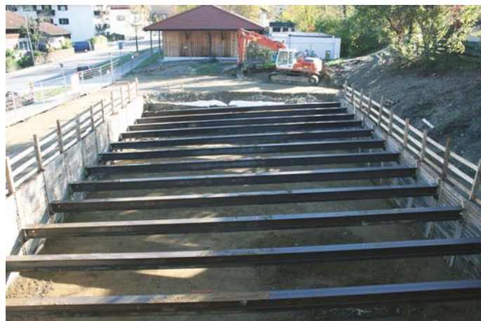
Die Baugrube des Erweiterungsbau musste mit einem Spezialverbau gesichert werden
