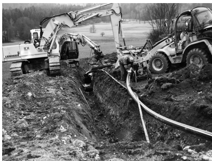
Die Ortsteile Stampfl, Schweinsteig, Achental und Linden werden nicht vom Kanalanschluss-Zwang befreit. Die Planungen für den 3. Bauabschnitt bleiben unverändert. In diesem Frühjahr werden die Bauarbeiten bei der Druckleitung fortgesetzt
