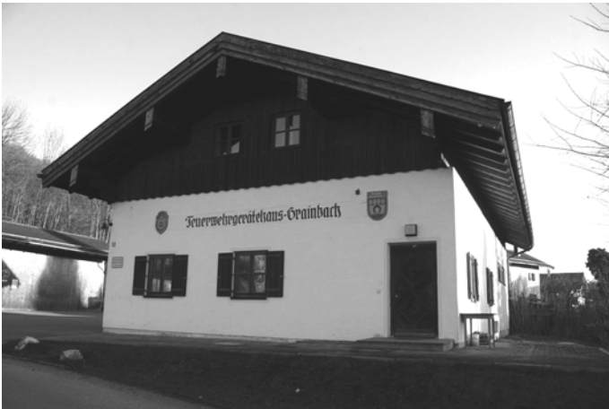
Grainbacher Feuerwehrhaus – soll zukünftige eine Probenbleibe für den Trachtenverein Hochries-Samerberg werden.
